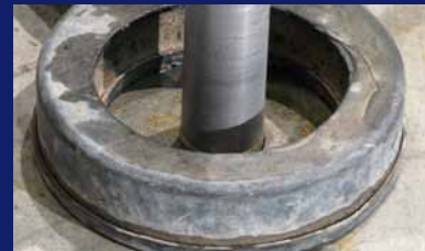
Bohren der Löcher
