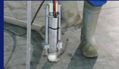
Injizieren des flüssigen Schaumbetons
