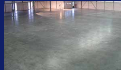
Nivellierter, bearbeiteter Hallenboden
