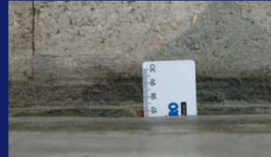
Hohlraumfüllung und Anheben des Bodens
