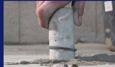
Verschliessen der Löcher mit Bohrkernen
